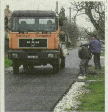
A befejezett csatornázás után aszfaltoztak. FOTÓ: BÍRÓ DÁNIEL
