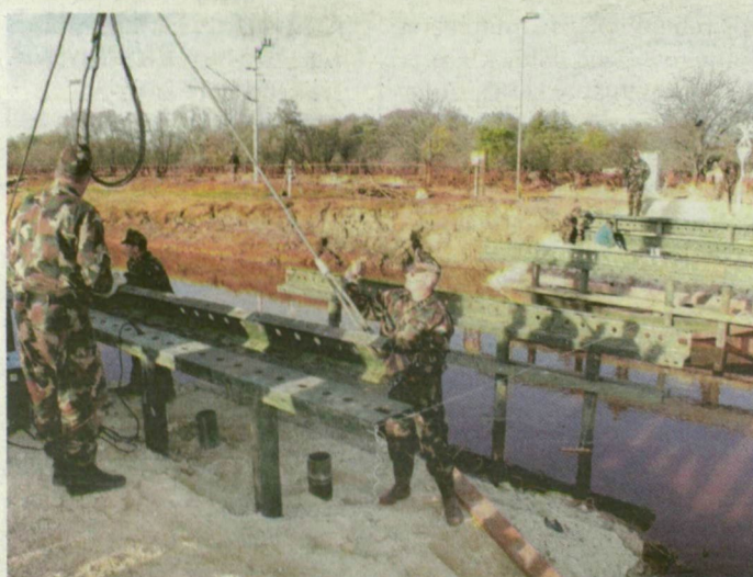
Vascölöpökre építették a hidat a szentesi műszaki ezred katonái. FOTÓ: MTI
