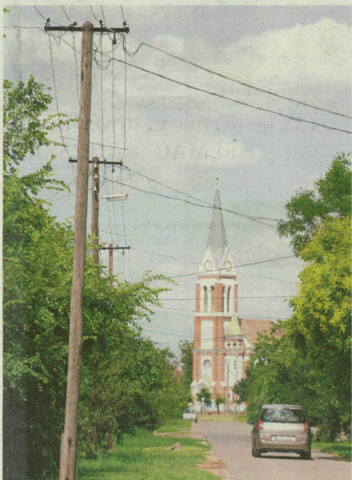
A Síp utca fölött az ég. Itt nem akart kábelt vezetni a szolgáltató a földben. FOTÓ: KARNOK CSABA
