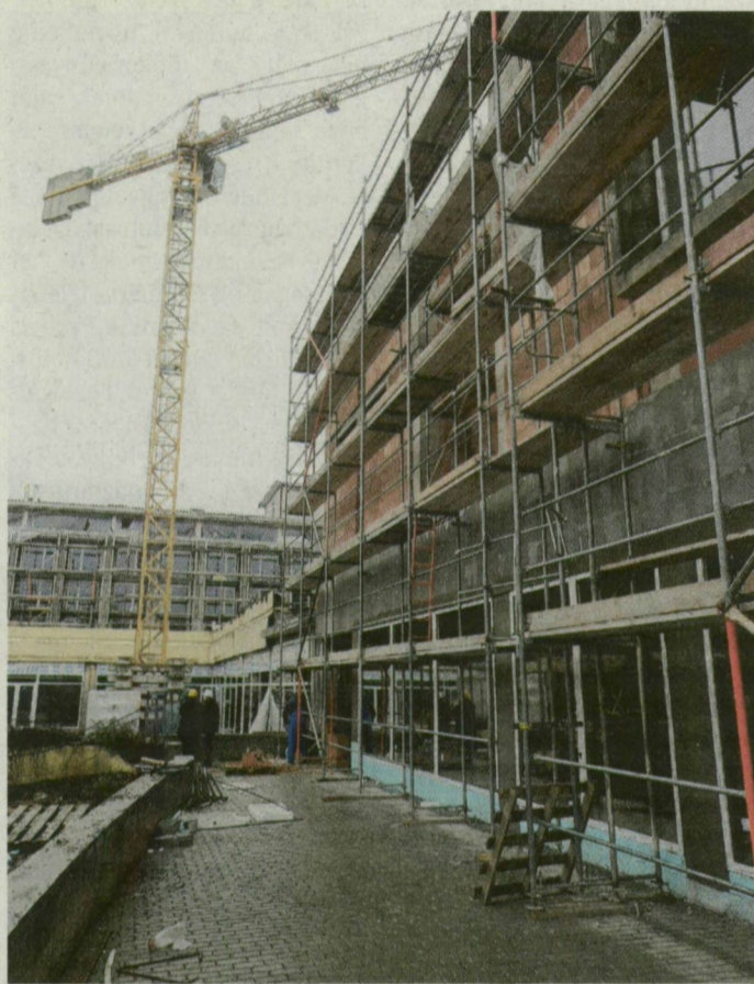
A felújítás alatt álló szegedi Forrás Szálló. FOTÓ: KARNOK CSABA
