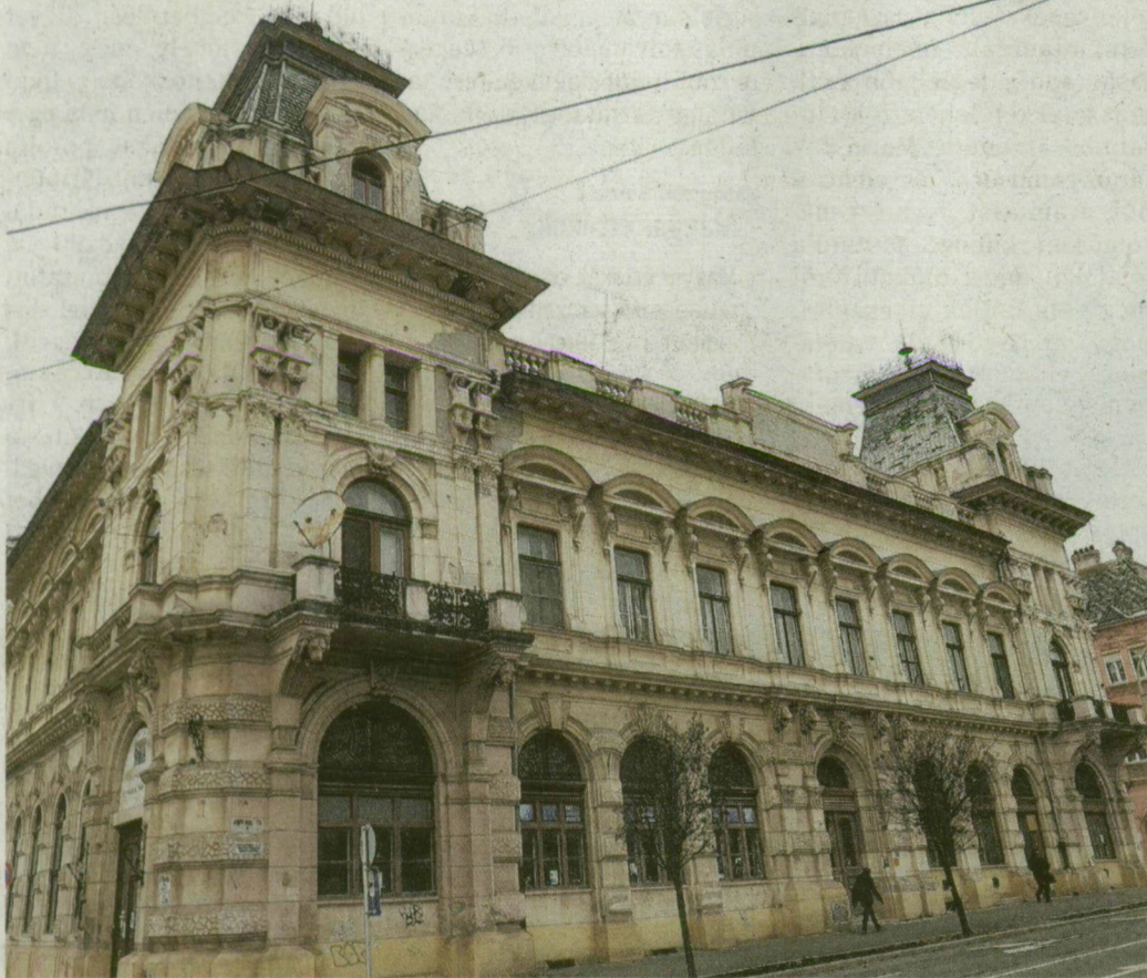
Az egyház azért nem veszi át a várostól az egész épületet, mert az nagyon elhanyagolt. FOTÓ: KARNOK CSABA
