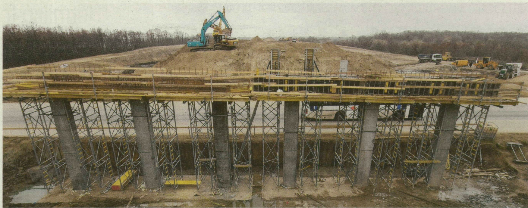
Az M43-as és a 47-es találkozásánál az egyik pillértartó oszlopsor már elkészült. FOTÓ: SEGESVÁRI CSABA
