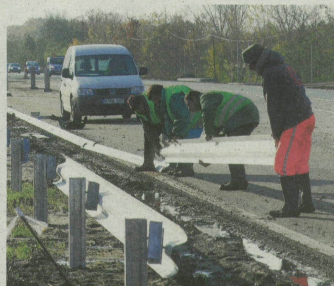
Még szerelik a védőkorlátot a kiszélesített út mentén. FOTÓ: TÉSIK ATTILA
