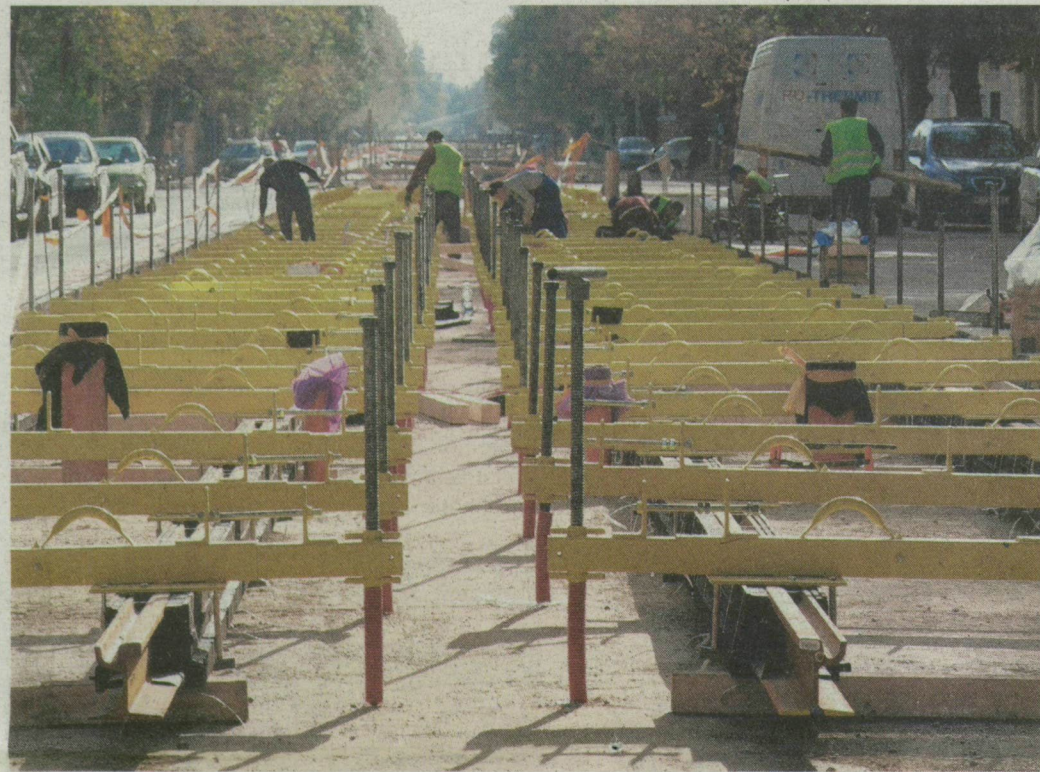
Pillanatkép a Boldogasszony sugárútról október 22-éről és tegnaptól. A már beszintezett vágányokat fel kellett szedni, mert gond van a sínek alapjával. Nem lehet tudni, hogy ez mekkora csúszást jelent. FOTÓK: KARNOK CSABA
