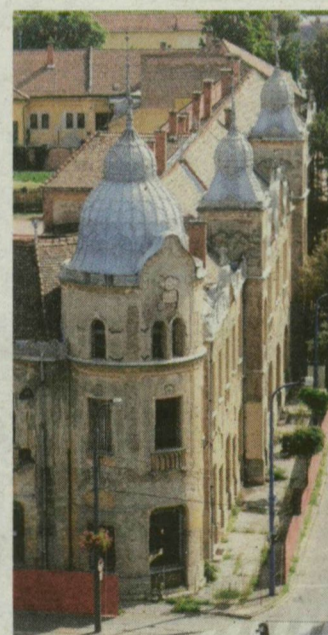
Hamarosan elkezdődhet a Petőfi Szálló felújítása. FOTÓ: TÉSIK ATTILA
