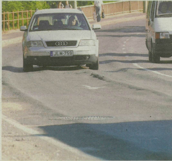
Nyomvályú a szegedi Bertalan hídnál. A kamionok nem kímélik az aszfaltot. FOTÓ: SEGESVÁRI CSABA
