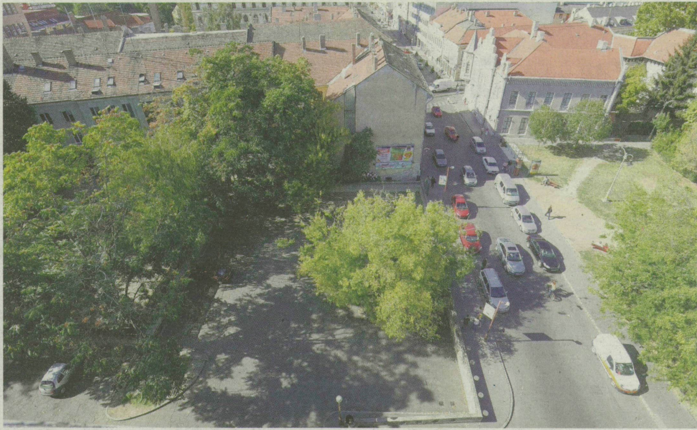
Jövőre megkezdődik az építkezés a Somogyi-könyvtár mellett, a sörkert helyén. FOTÓ: KARNOK CSABA
