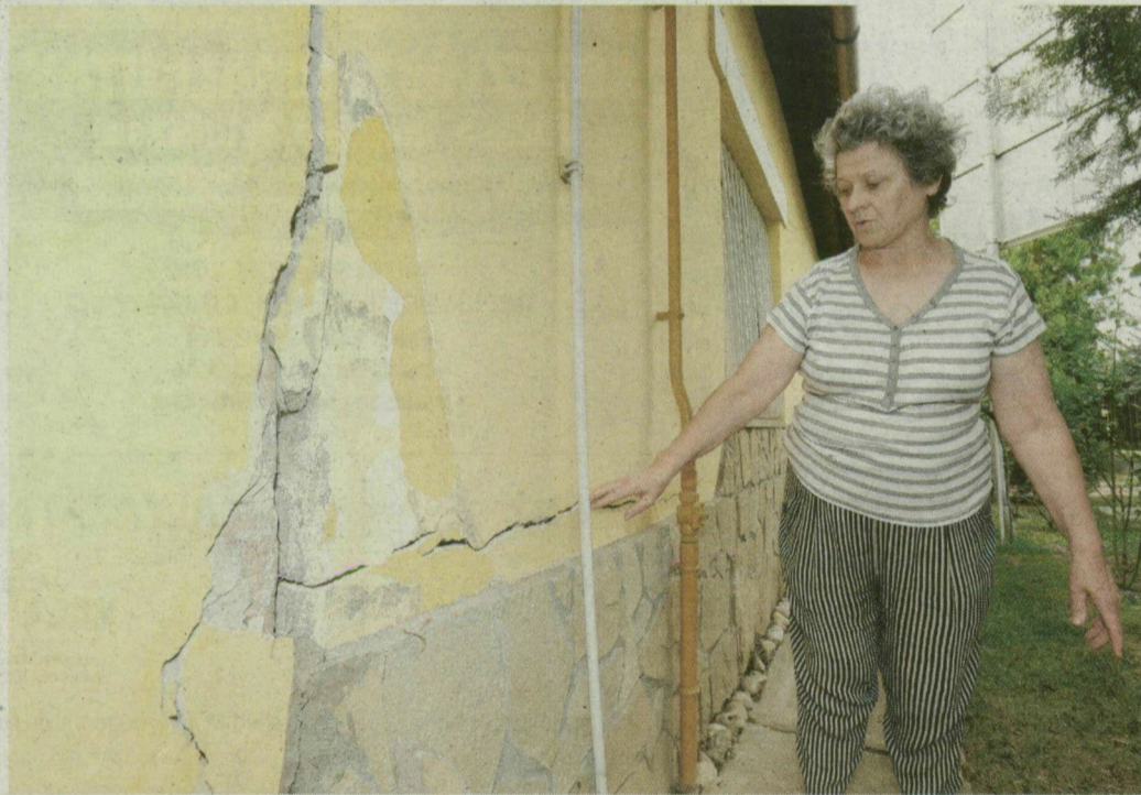
A három éve felújított ház fala több helyen megrepedt – mutatja Popovics Zoltánné. FOTÓ: KARNOK CSABA
