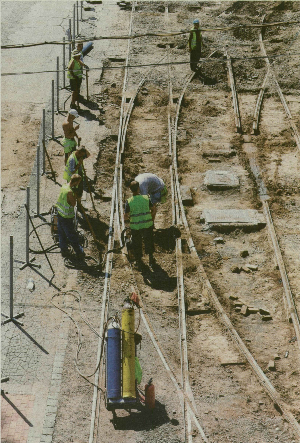
Drót már nincs, most a sínek vannak soron. A Pulz utcai remíz vágányhálózata is megújul. FOTÓ: KARNOK CSABA
