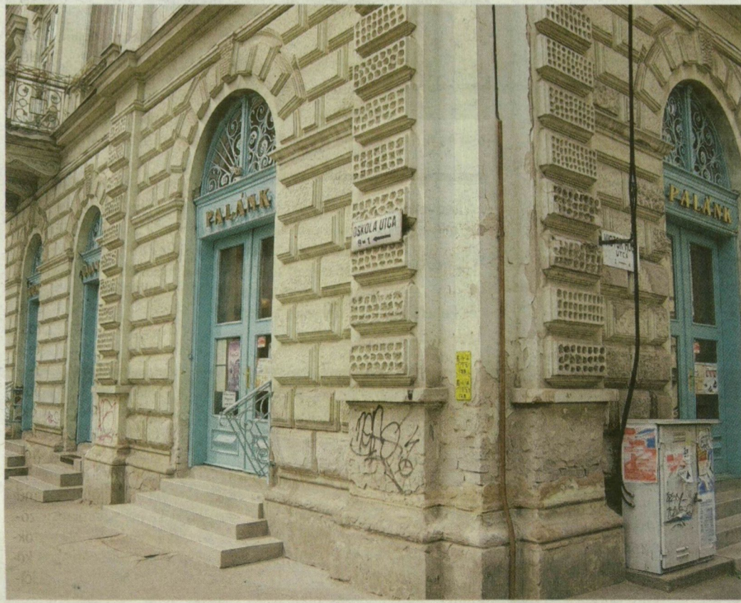
Kívül-belül felújítják a Palánk cukrászda épületét. FOTÓ: FRANK YVETTE
