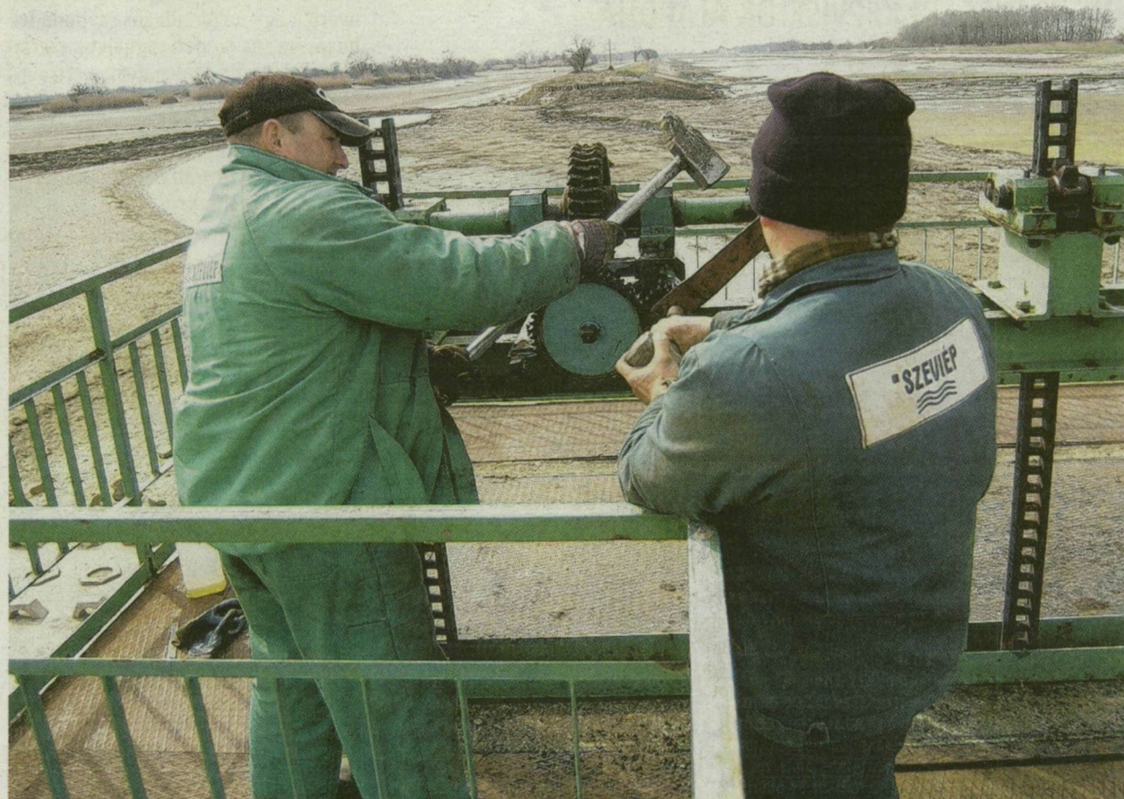
■ MOST MÉG MAGÁTÓL FOLYIK BEFELÉ A VÍZ. HA KIEGYENLÍTŐDIK A SZINT, BEINDULNAK A SZIVATTYÚK IS
