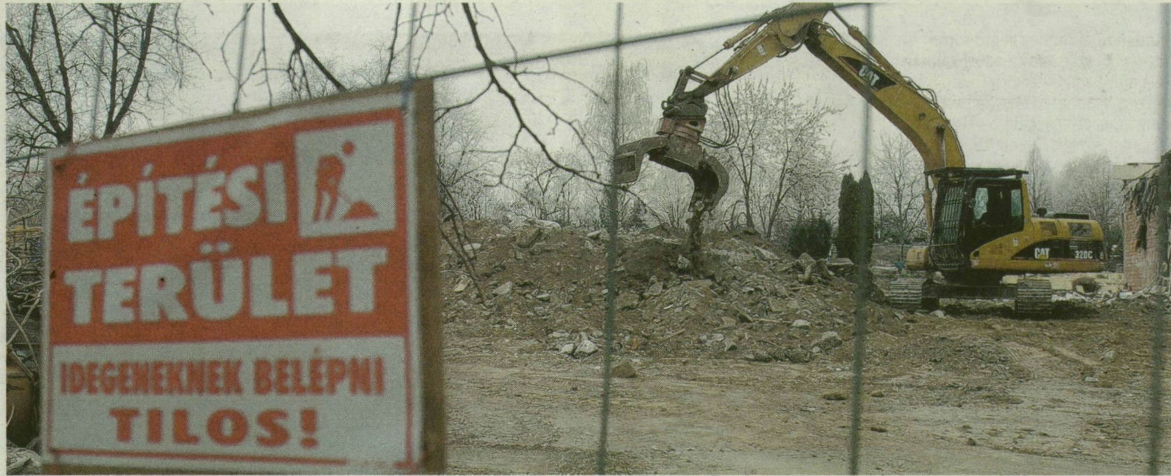
■ AZ IDEGENEKNEK TILOS, A MUNKÁSOKNAK MOST ÜNNEPRONTÓ ÉPÍTÉSI TERÜLETRE LÉPNI
