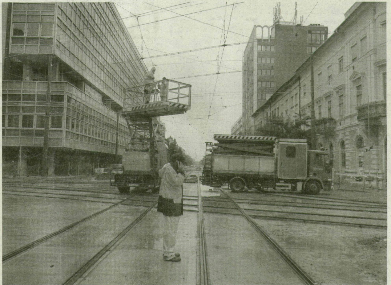
„PÓKHÁLÓZZÁK” AZ EGET A PLAFONTAPASZTÓK: KÉSZÜL A FELSŐVEZETÉK AZ ANNA-KÚTI KERESZTEZŐDÉS FÖLÖTT Fotó: Karnok Csaba
