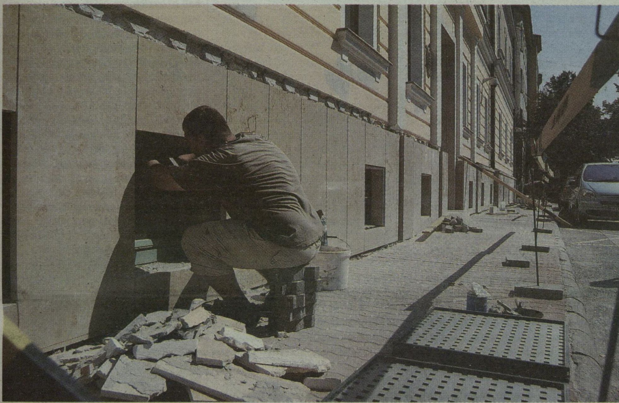
ÚGY LÁTSZIK, A VAKOLATOT ÉS A LÁBAZATOT EREDETEILEG CSAK NYÁRI HASZNÁLATRA SZÁNTÁK A KIVITELEZŐK Fotó: Frank Yvette
