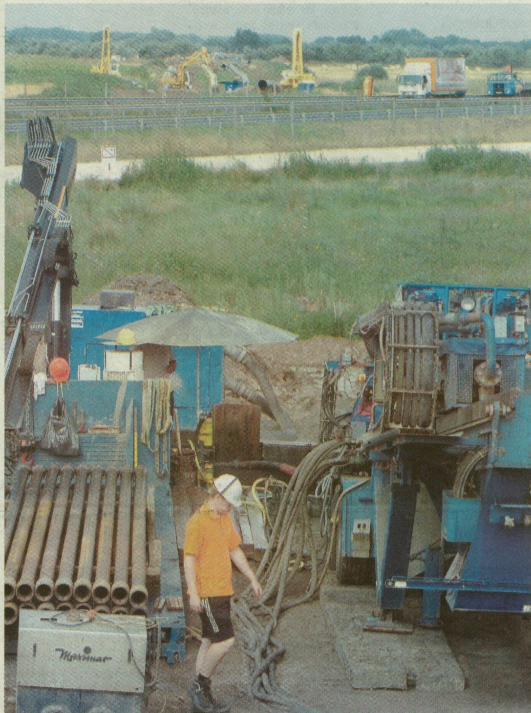
■ Érkezési oldal. A holland fúrógép húzza át az úttest alatt a gázcsövet
