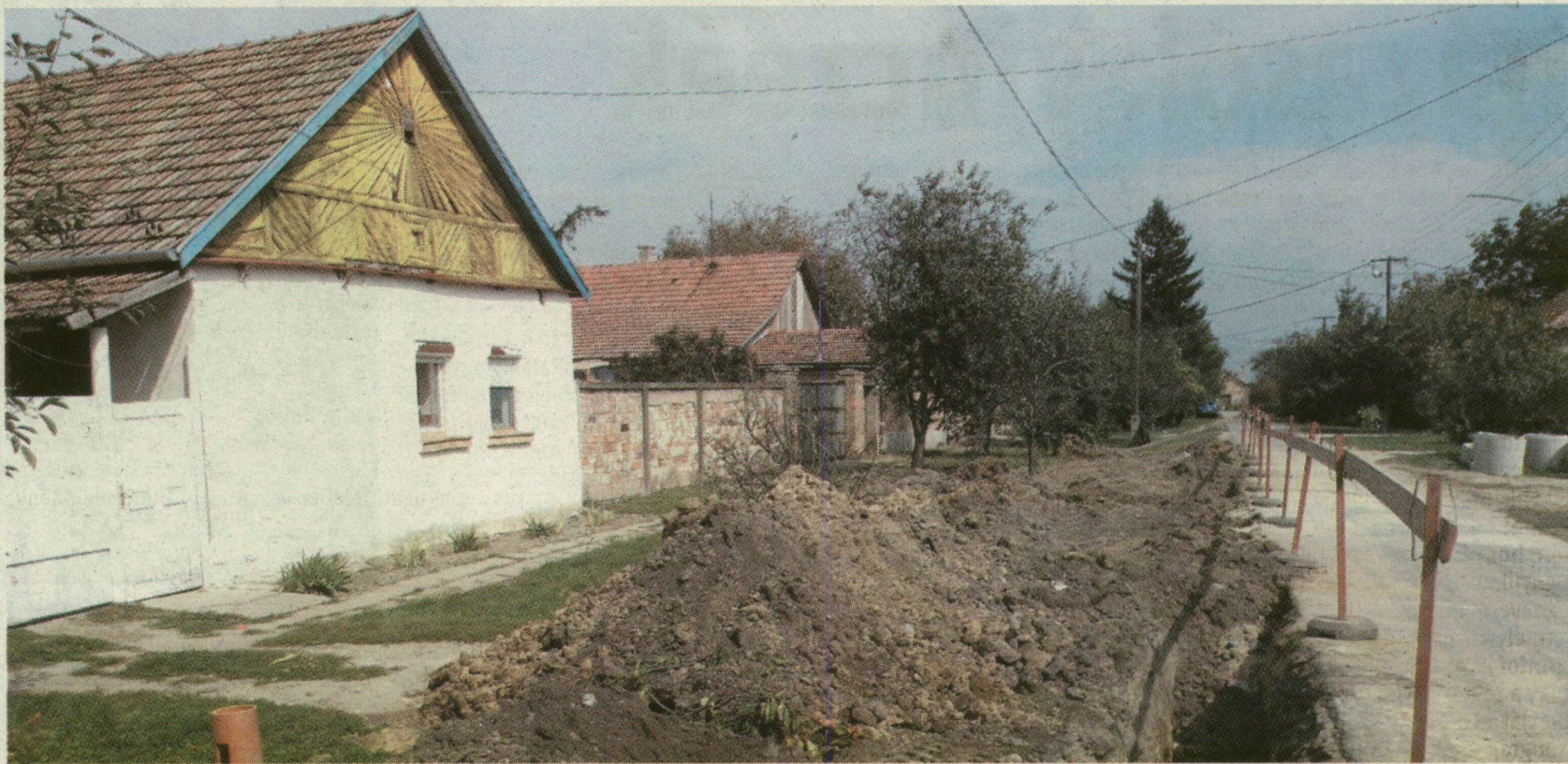
TÖBB ÉVEN ÁT ÉPÜLT A GYORSAN FEJLŐDŐ DESZK CSATORNAHÁLÓZATA
