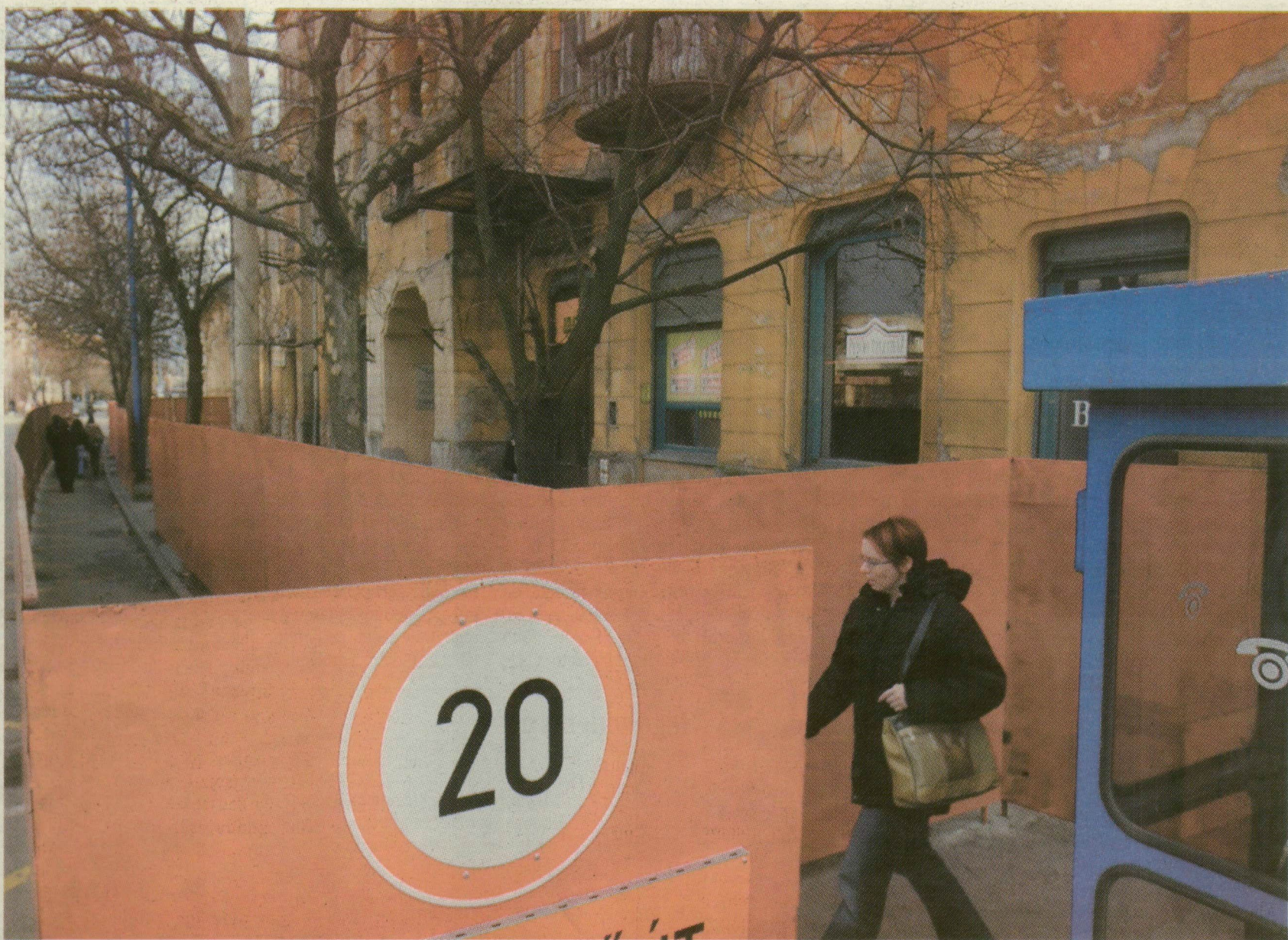
■ KACSKARINGÓZÁS AZ ÉPÍTKEZÉS MIATT. A SZÁLLÓT KÖRBEVETTÉK PALÁNKKAL, AZ ELŐKÉSZÍTŐ MUNKA FOLYIK ODABENN
