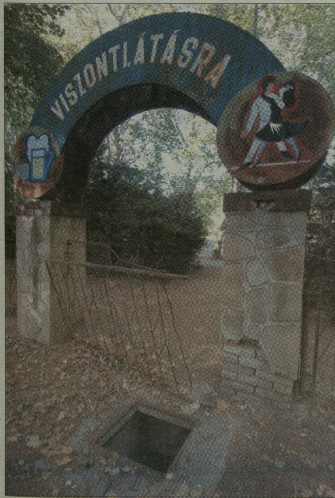
A Vigadó bejárata szomorú képet mutat, és balesetveszélyes is
