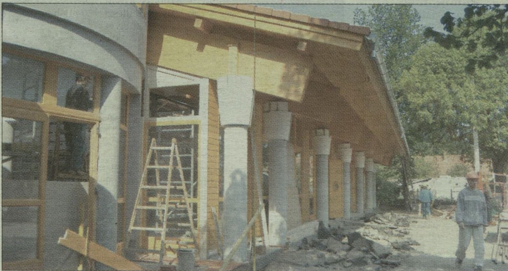
Utolsó simítások a műszaki átadás előtt az iskola új szárnyában
