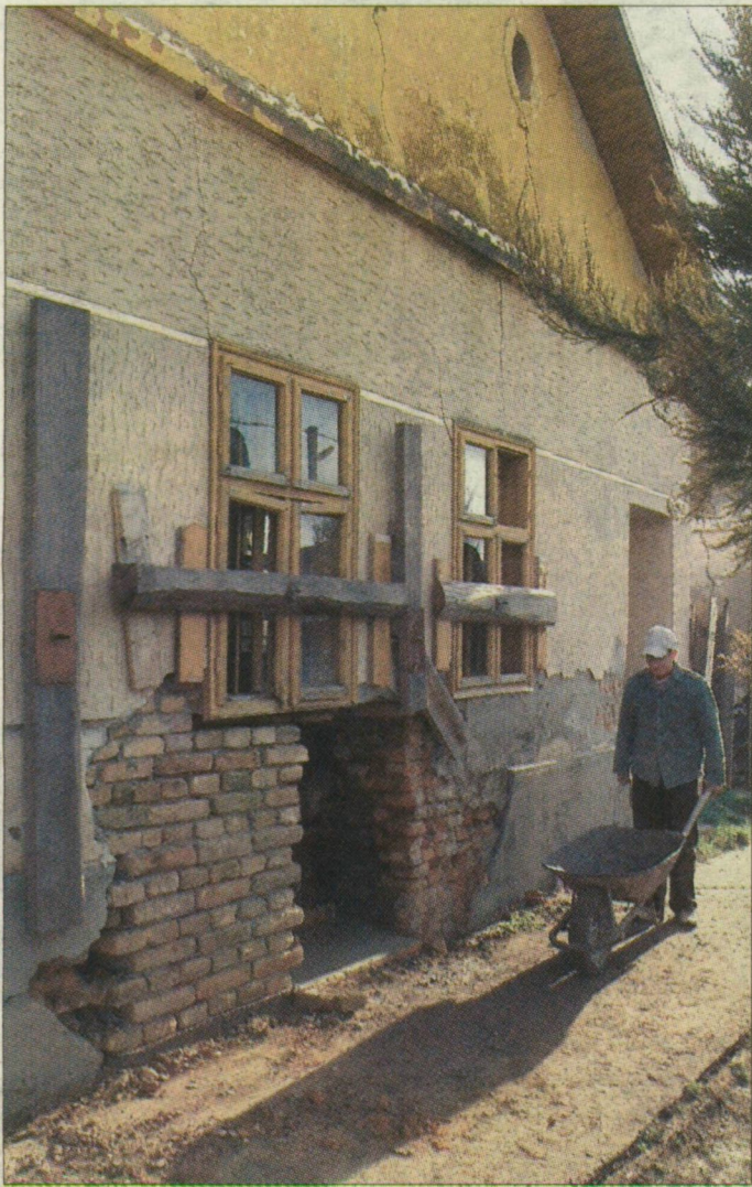
A munkával lassan halad a rekonstrukciót végző csapat: a vályogházat újra kell alapozni Fotó: Gyenes Kálmán
