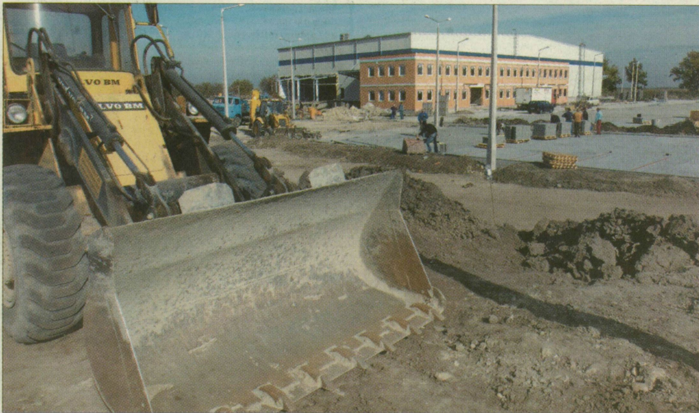
Az első épület a hatalmas telek sarkában
