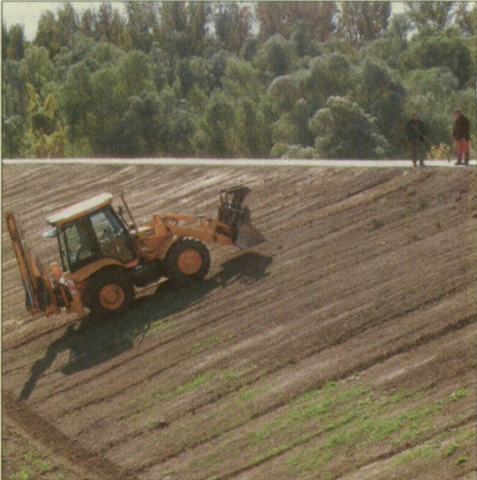
Töltésepítés. Csanyteleknél olcsó lenne, de a körbekerített föld túl értékes
