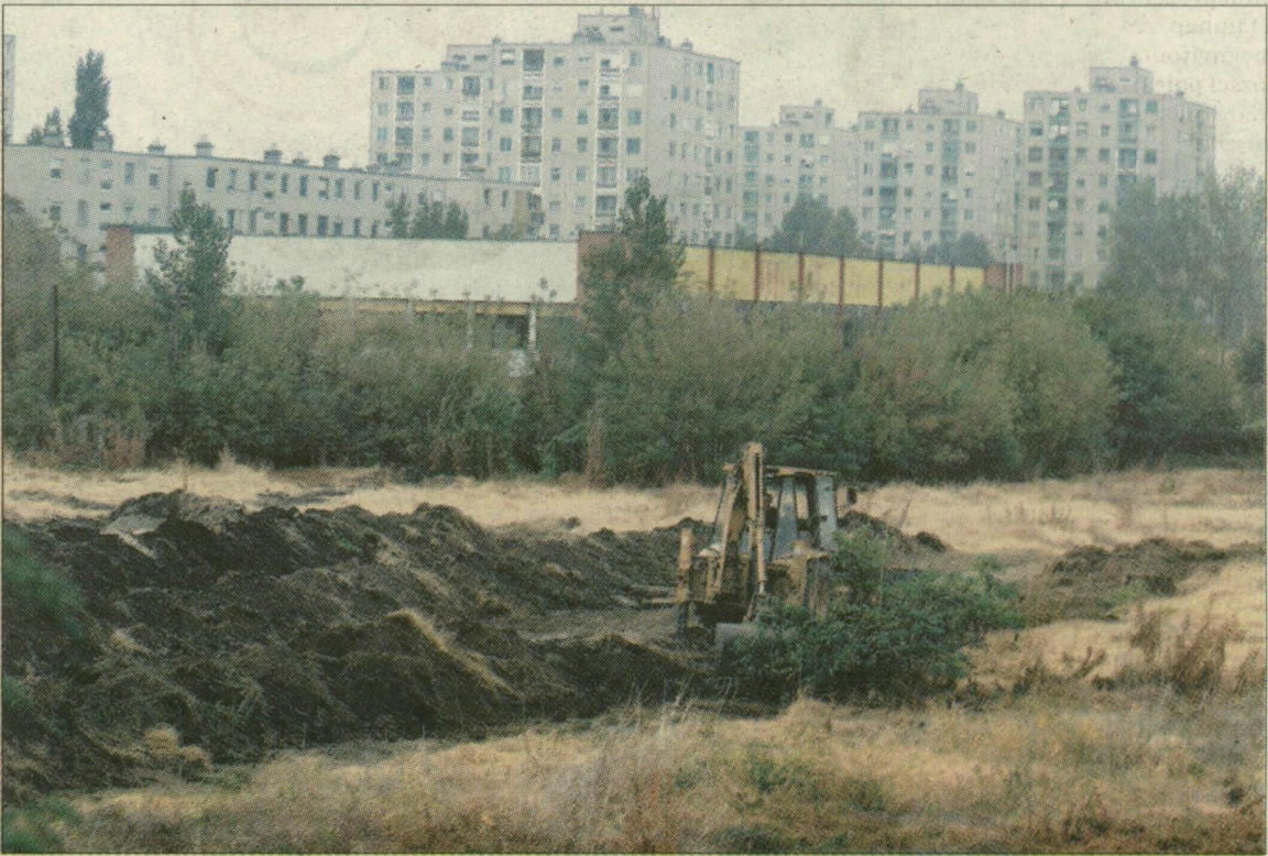
Közművezetéknek és feltáróútnak ágyaz a markoló
