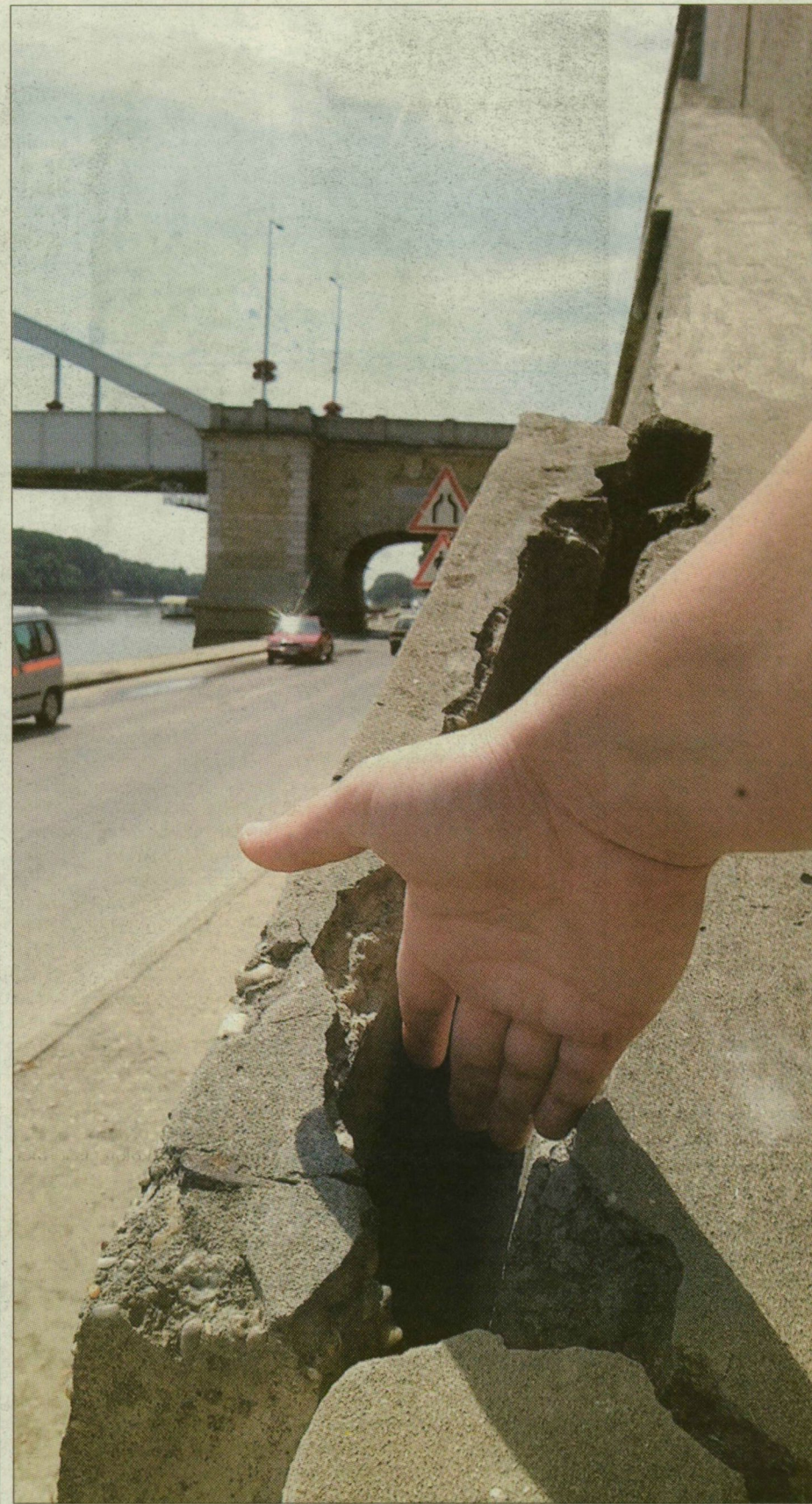
Repedések a partfalon. A fölüjtás mindenképpen szükséges
