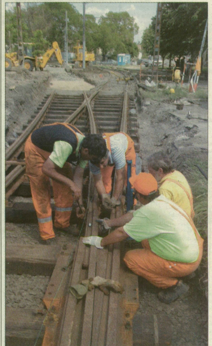
Villamos kiterő épül a Vám téren. A vonal vizsgálati azt mutatják, hogy a legjobb keresztezési pont az egymással szembe haladó kocsik számára a Vám téren adódik – mondta Dózsa Gábor, SZKT igazgató. Most a Szivárvány kitérőnél átlagosan két percet vár a Keckésre tartó villamos, az új kitérő miatt júliustól egyenlethebb lehet a vonalon forgalom
