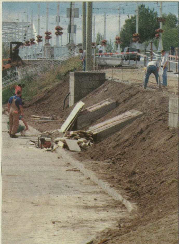
Felújítják a híd járdáját is a parkoló mellett
