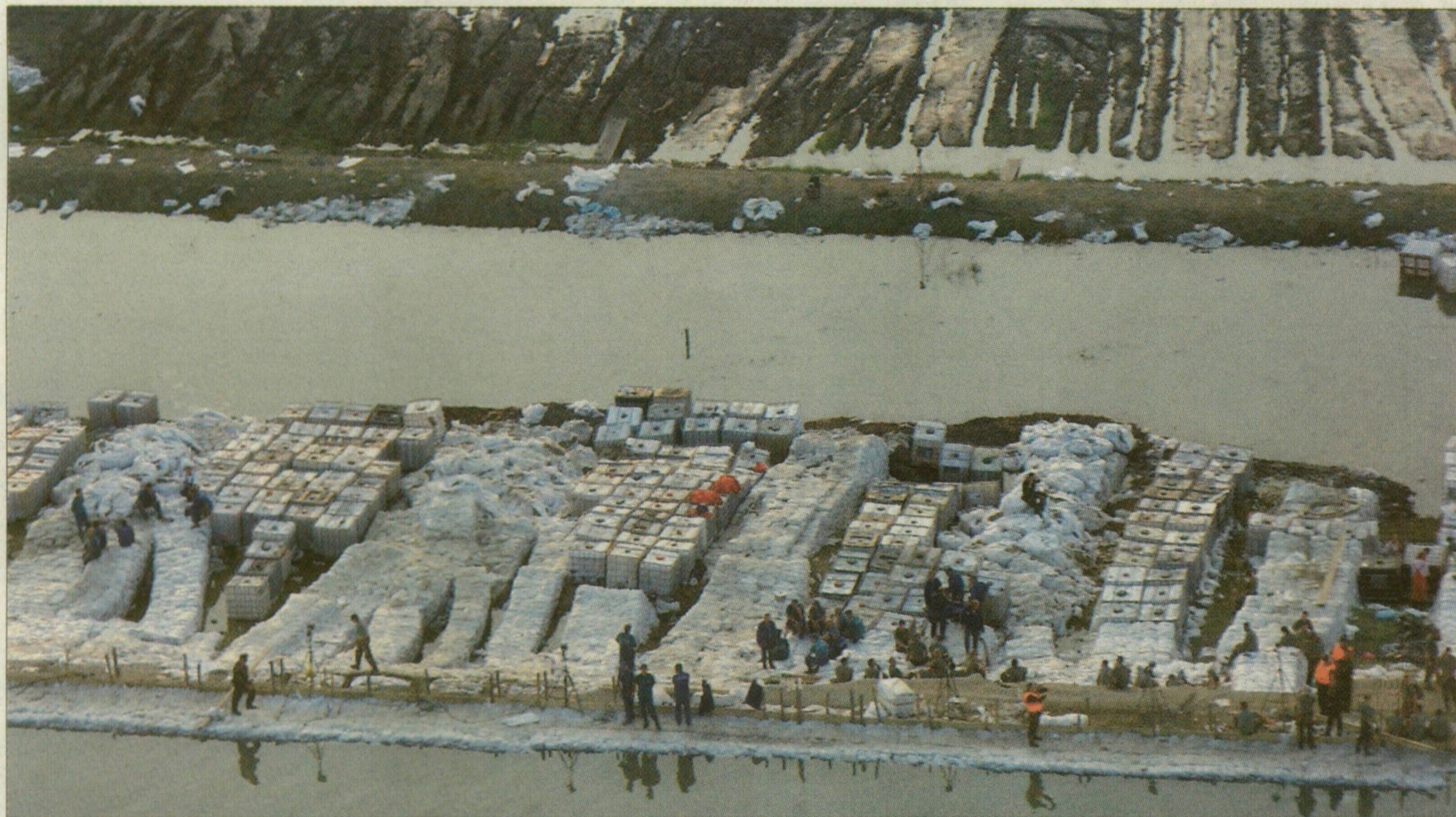
A Csongrád melletti Nagyrétnél alaposan meg kellett erősíteni a gátat. A munka sikeres volt
