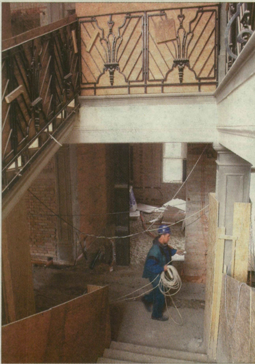
A belső tér átalakítása és a tetőzet rekonstrukciója mellett az udvart és a homlokzatot is felújítják
