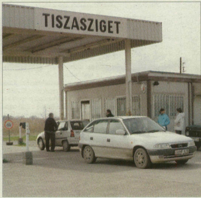
A tiszaszigeti határátkelőre ráfér a felújítás. A munkát pénteken kezdik el Fotó: Frank Yvette
