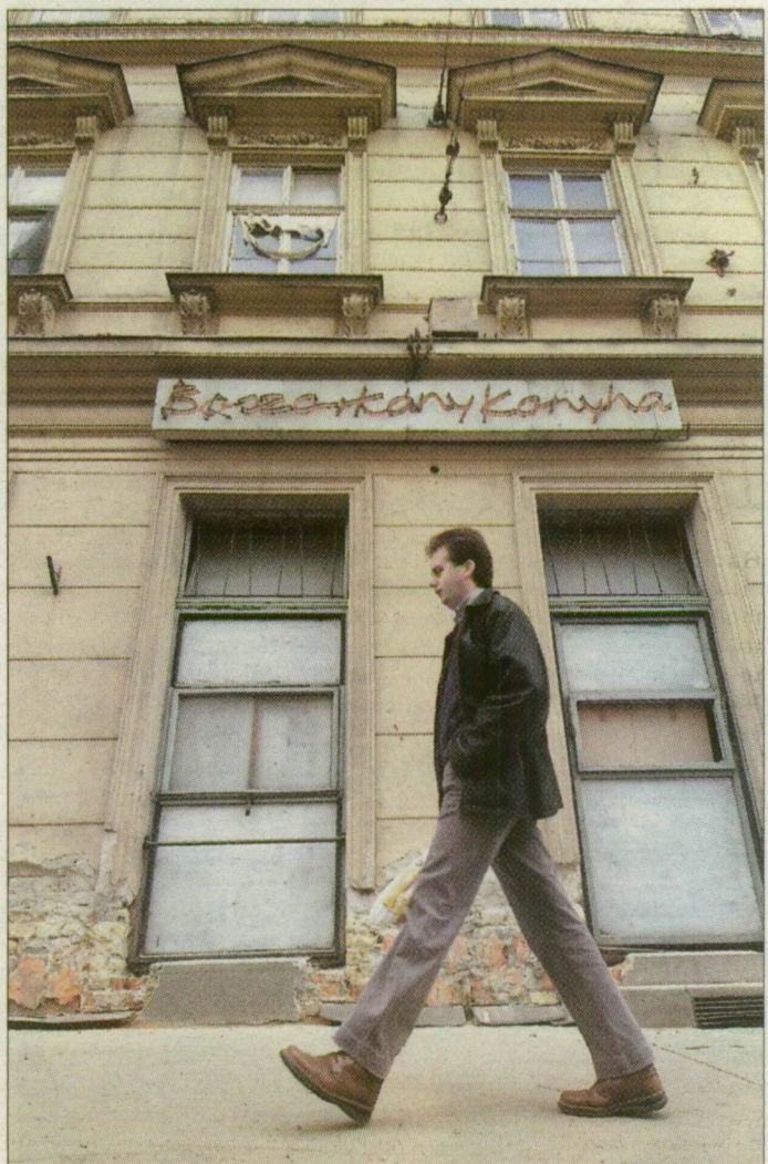
A Boszorkánykonyha felújítás közben
