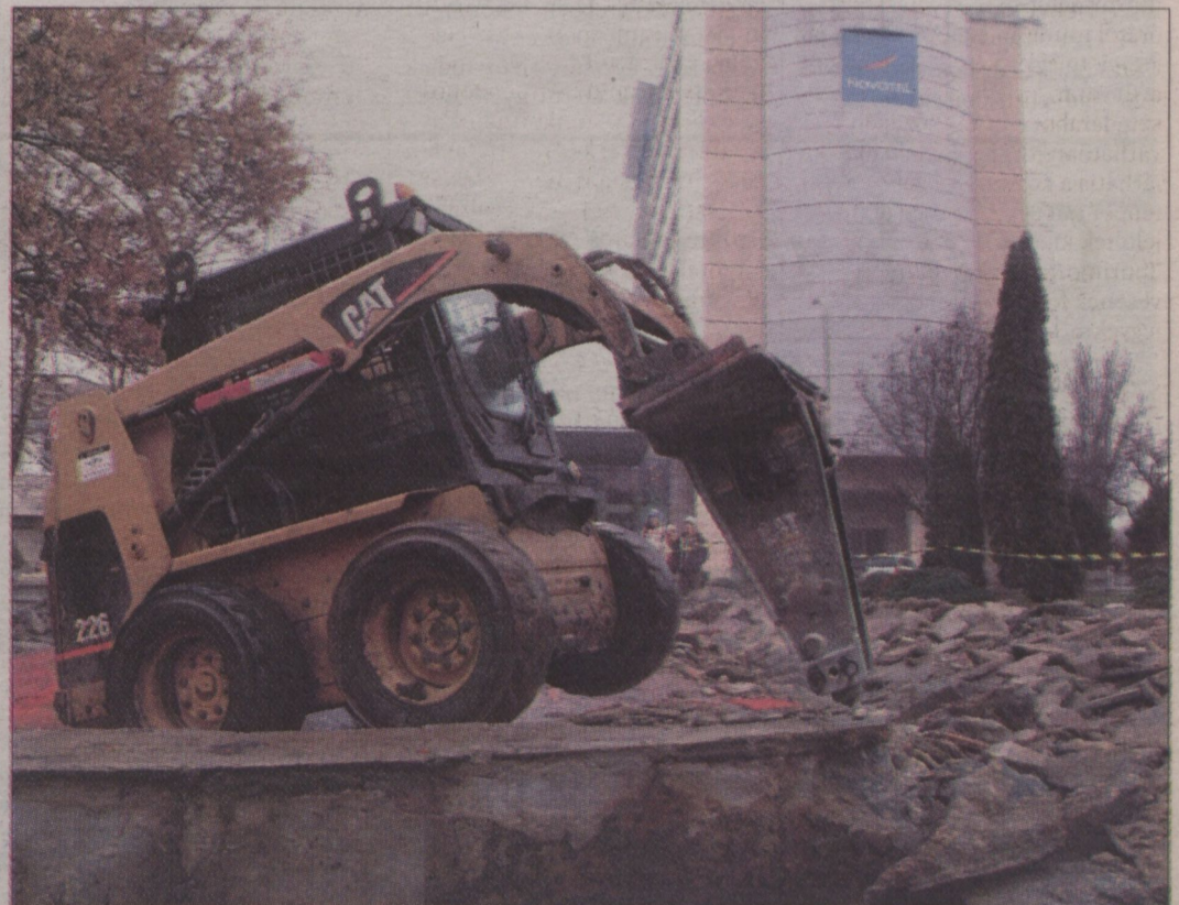
A szegedi Felsőváros kapuja, a Glattfelder tér tavaszra megszépül. A 30 millió forintos parkrekonstrukciót elkezdtek: a szökőkutat a gépészeti aknával együtt elbontják. A terv szerint a helyére kör alakban újat építenek, melynek középpontjába helyezik el Lapis András szobrászművész „kalapos hölgyét”: a Szegedért Alapítvány díjának 2,4 méter magas, 500 kilós bronzváltozatát
