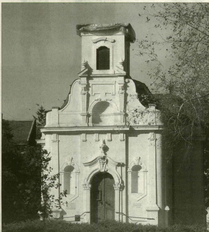
Átmenetileg csonka tornyú lett a görög katolikus templom
