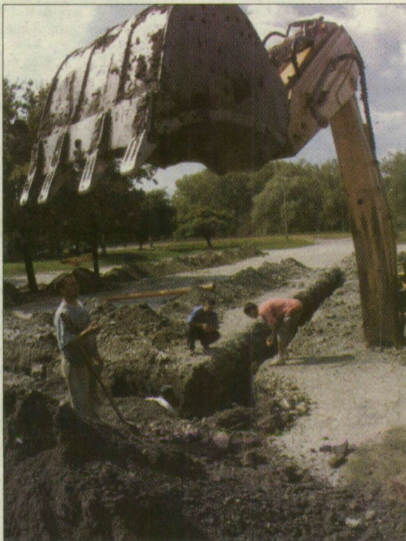
Vízvezető csatornák ásásával kezdődött el a Torontál tér rekonstrukciója
