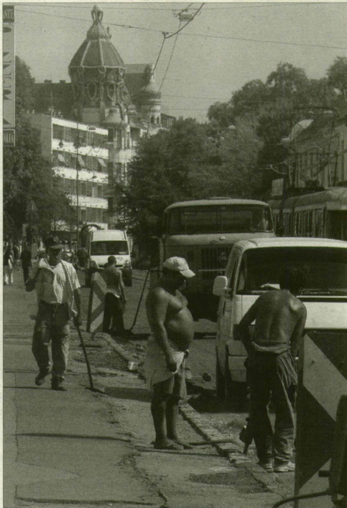
Az aszfaltszőnyegezést előtti utolsó simításokat végzik a munkások
