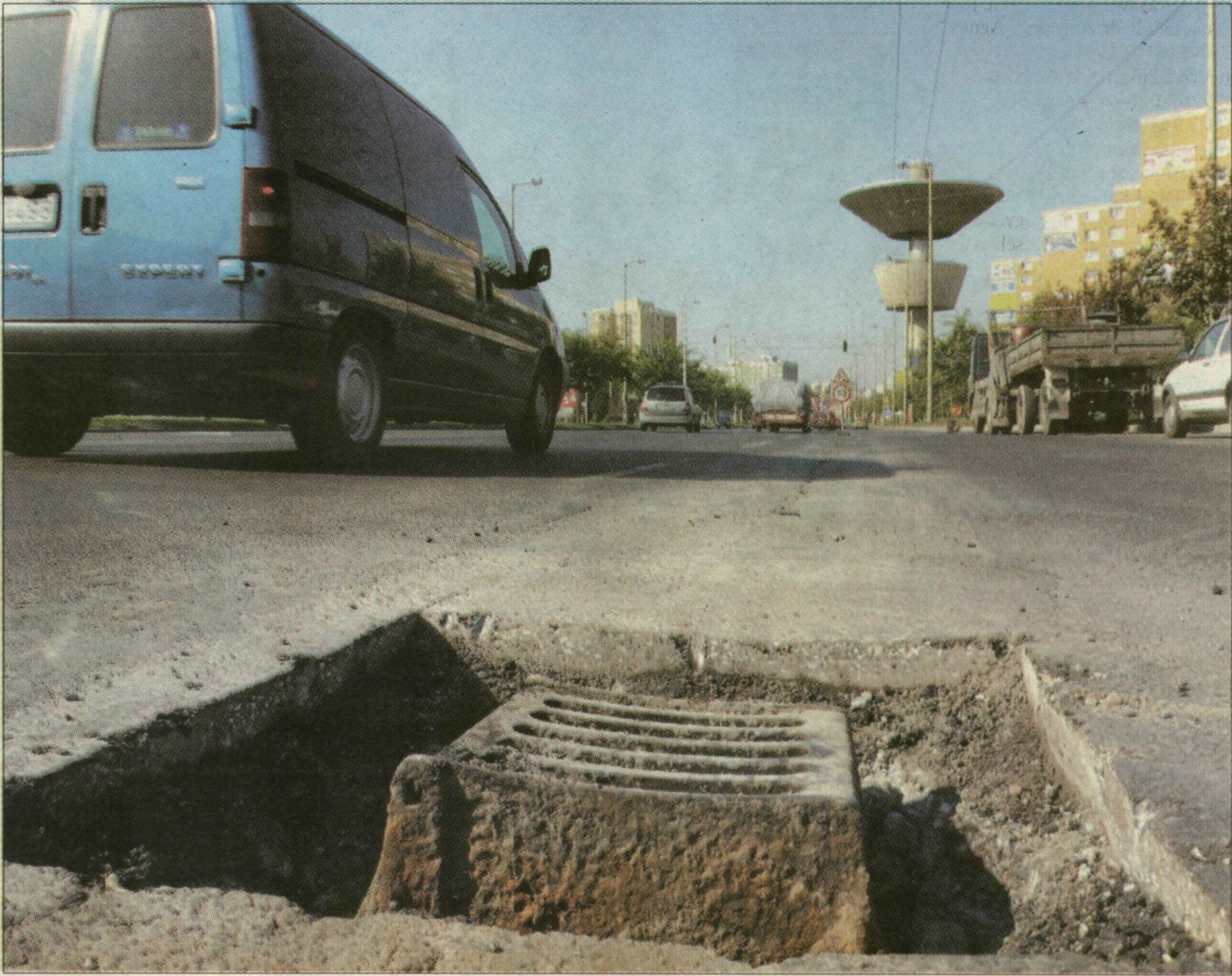
A Rókusi körúton újraaszfaltozzák a vízelvezetők környékét, mert eredetileg túl magasra emelték a burkolatot
