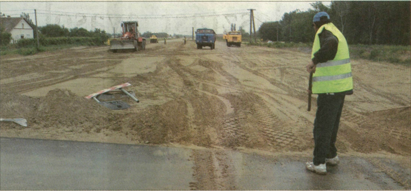
Röszke mellett már épül az M5-ös határig vezető szakasza
