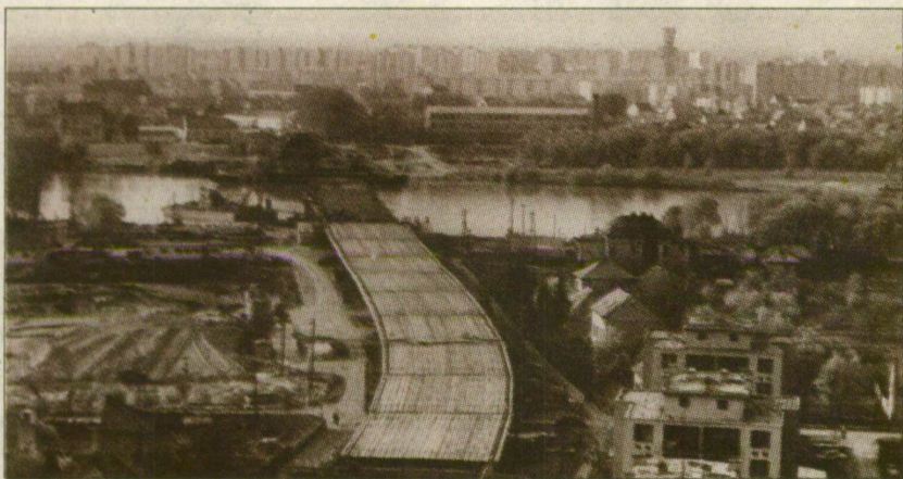
Már kivehető az épülő híd enyhe íve
