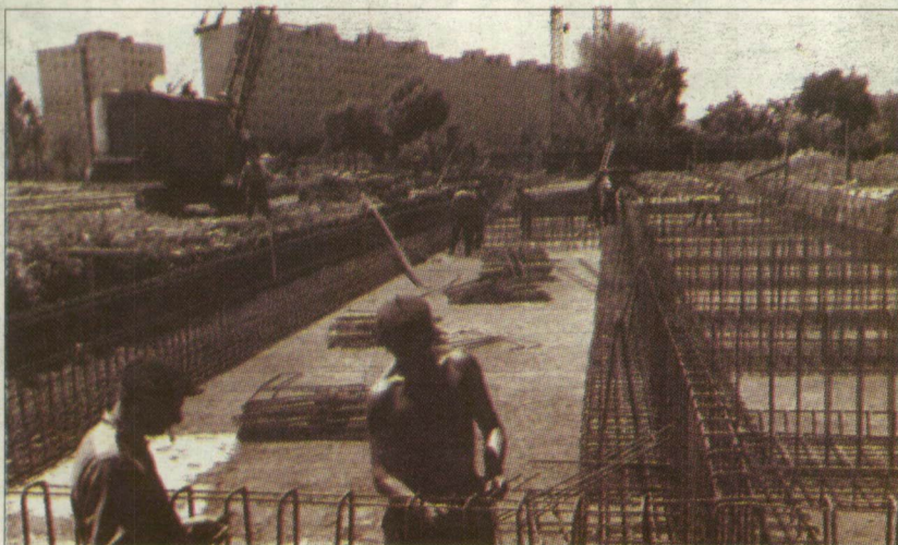
Épülnek a panelházak
