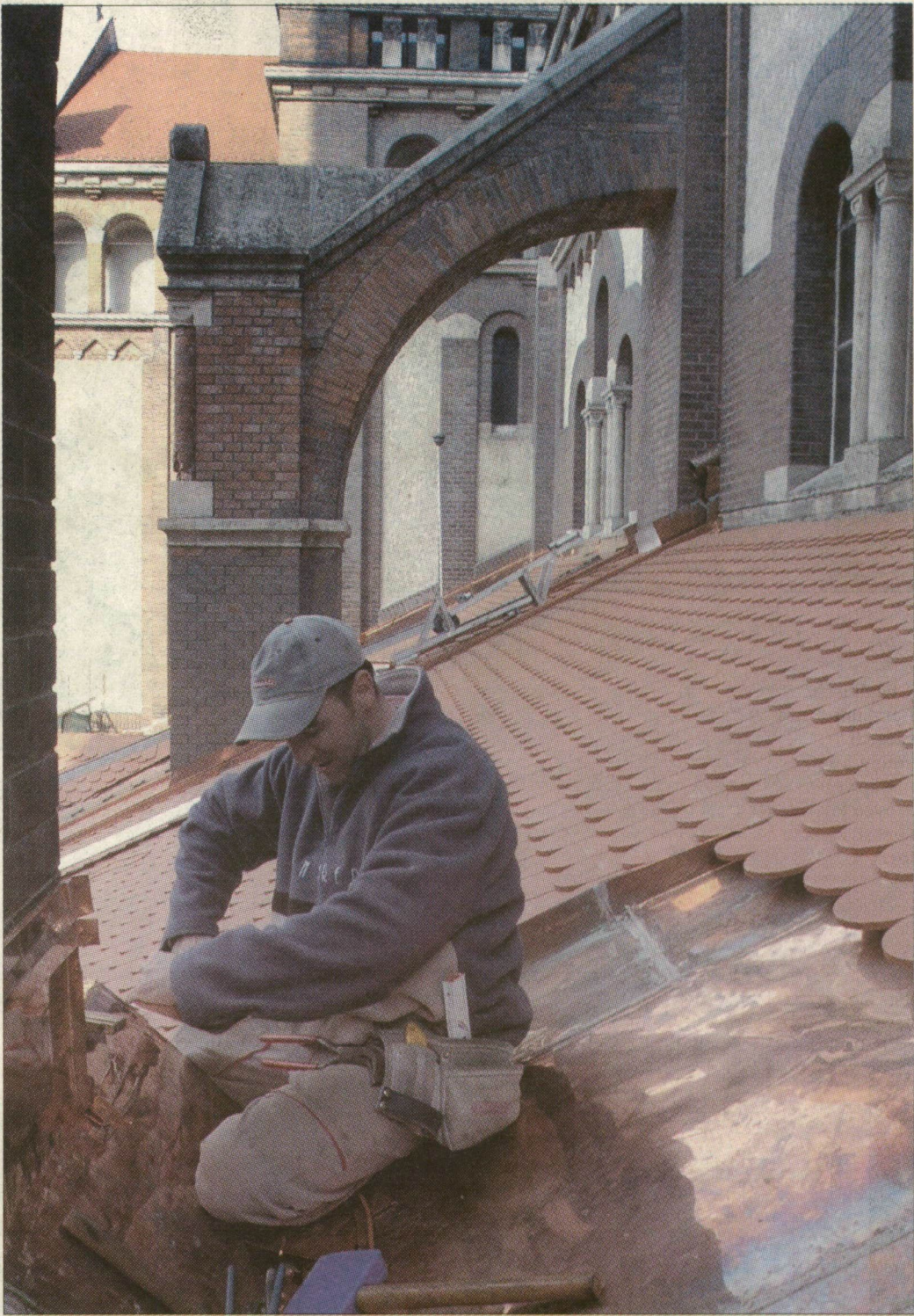
Csizmadia Gábor a dóm tetején. A fogadalmi templom tetőzetfőújítása hat tonna vörösrezt igényel
