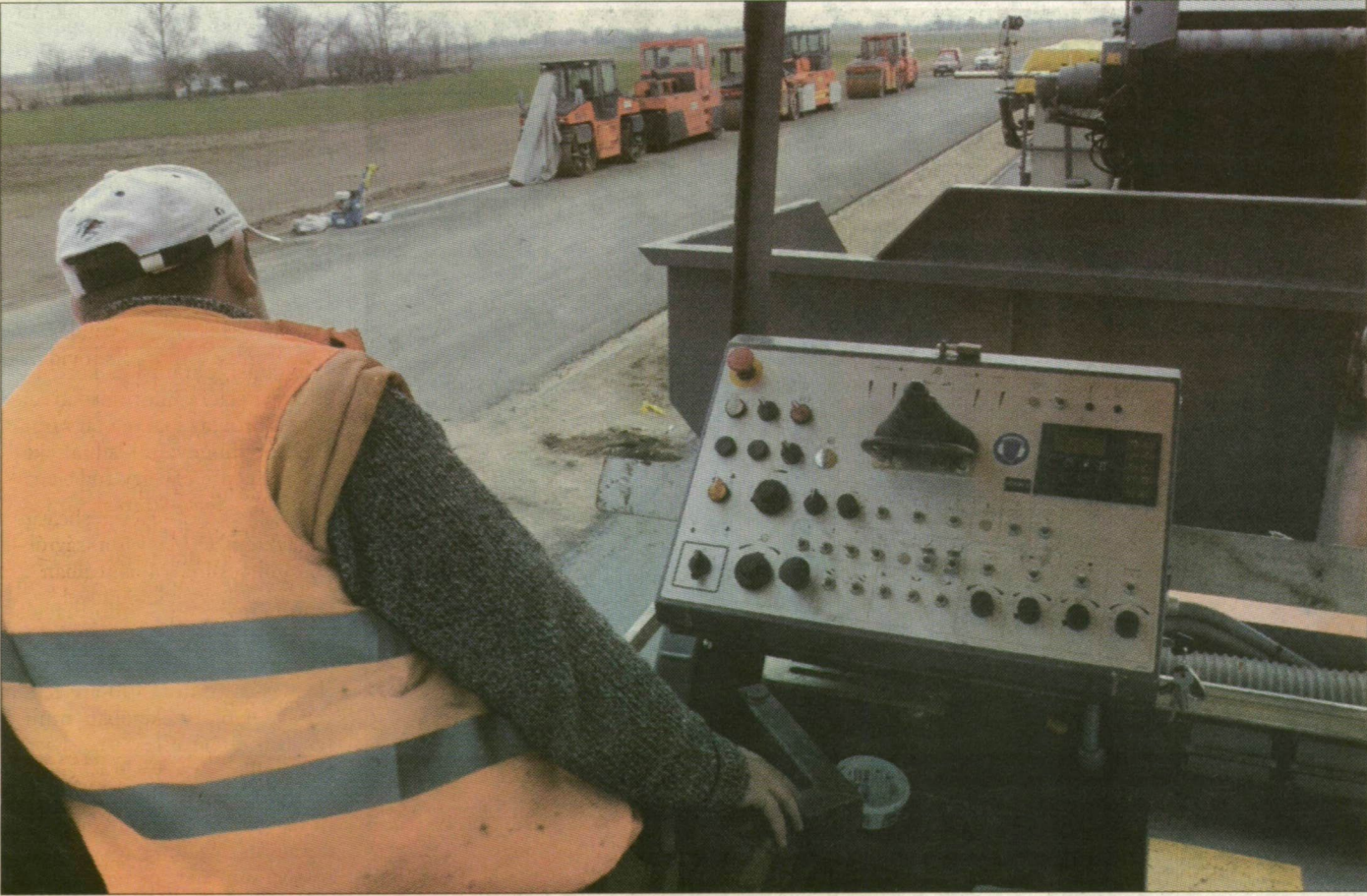
A következő réteg felhordásához készítik elő a már kész aszfaltcsíkot
