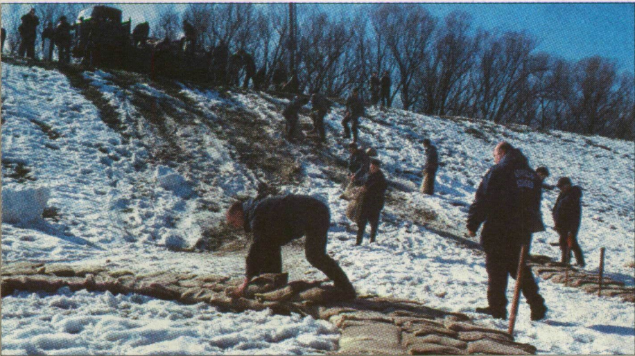
A töltést a gyakorlat során homokzsákokkal erősítették meg
