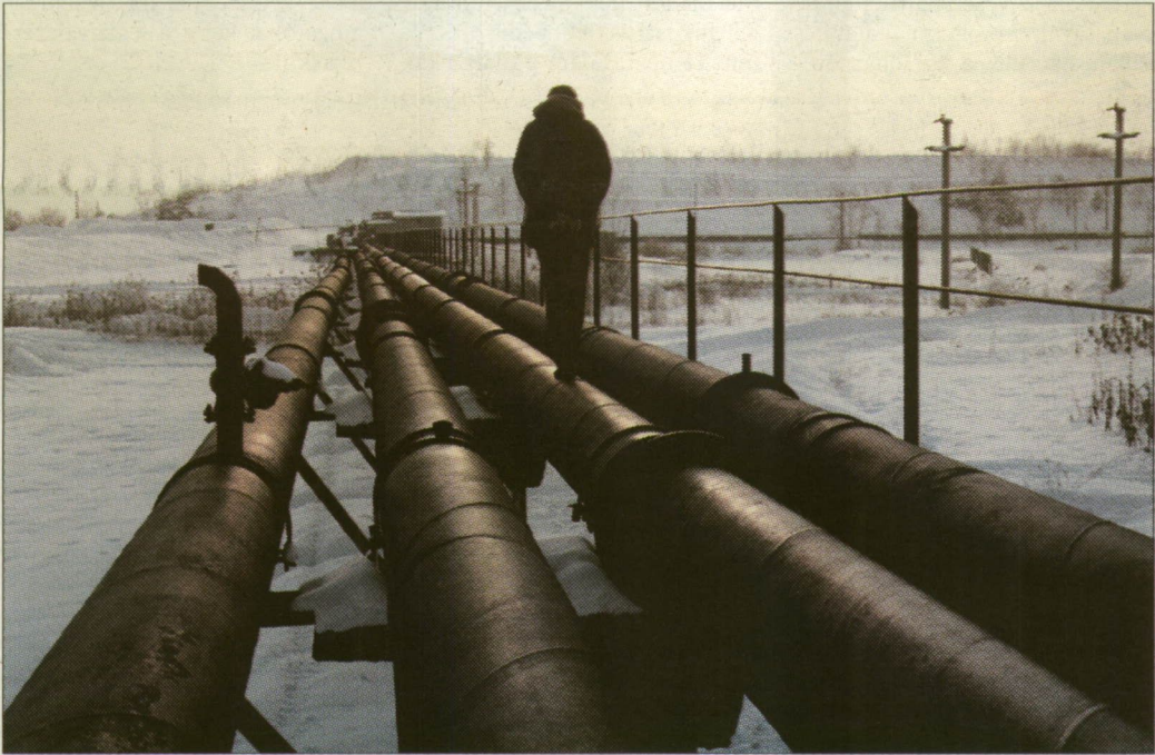
Nagybányán ezekben a csövekben vezetik el a cianós szennyvizet
