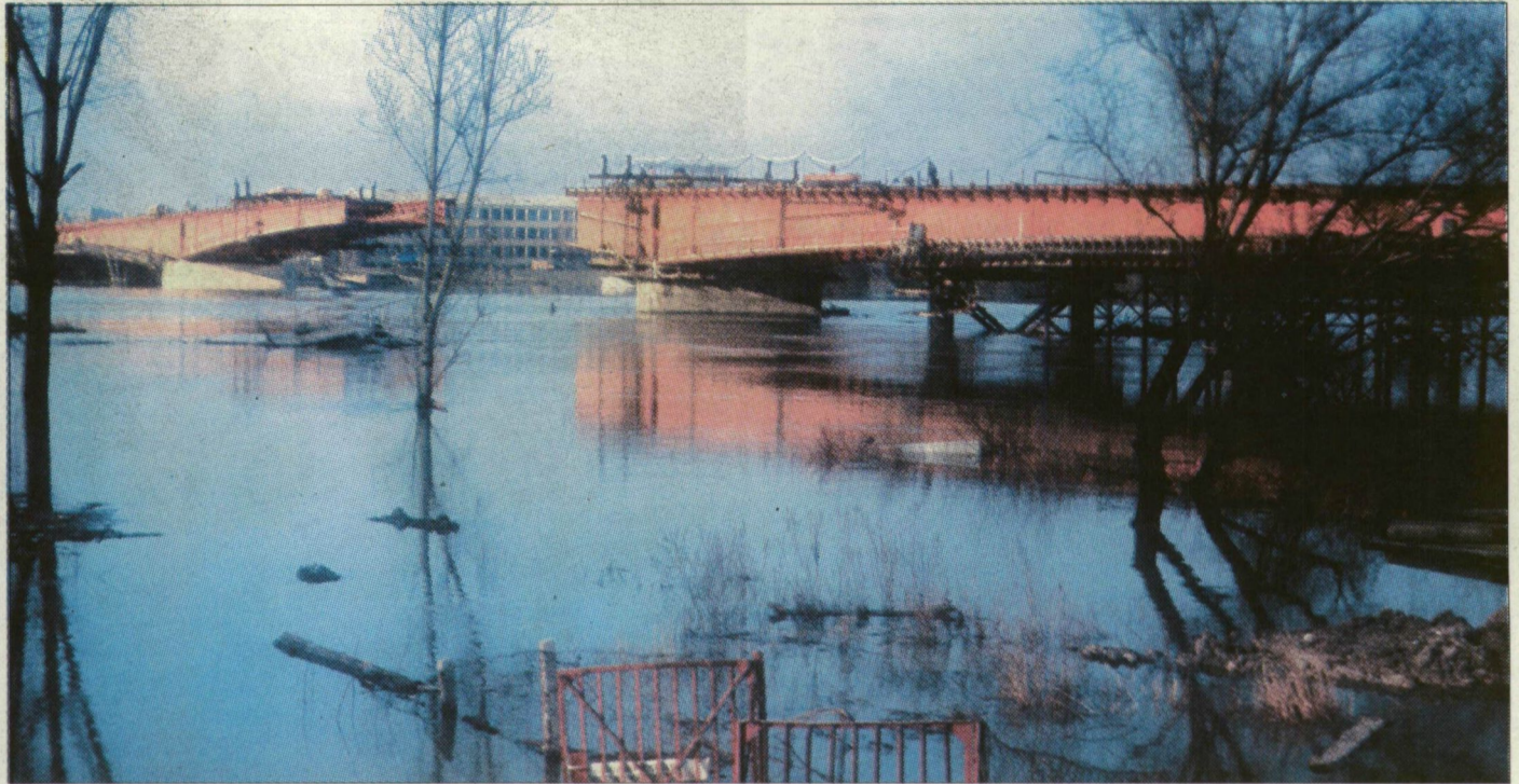
Bertalan híd, 1979. Az úgynevezett szabad szerelés árvíz közben Fotó: Gáll Endre
