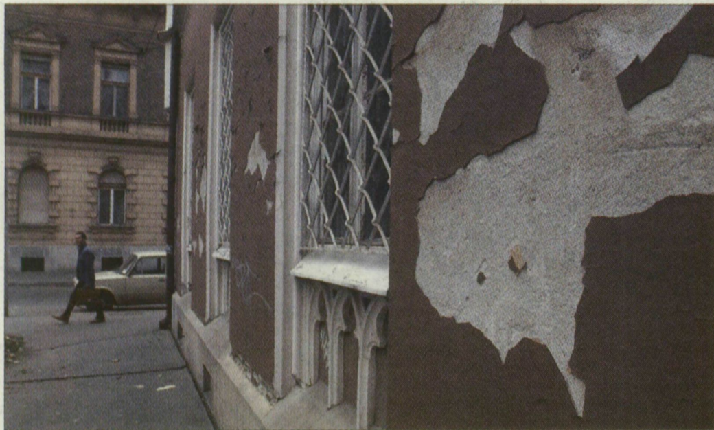
A hámló vakolat a beázáshoz képest csak esztétikai problémát jelent
