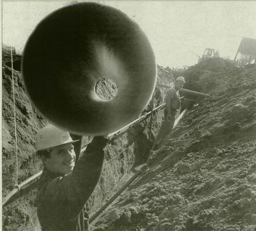
A munka jól halad, a település több pontján épül a csatornahálózat
