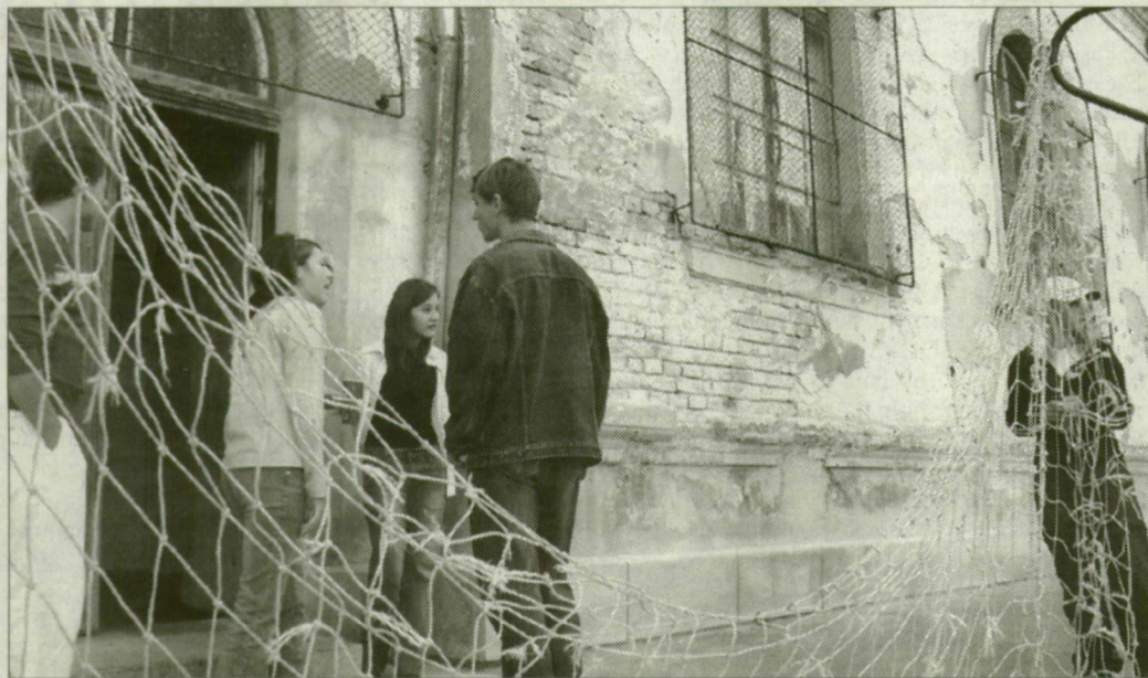
Az építőipari szakközépiskolások is részt vesznek az iskola felújításában
