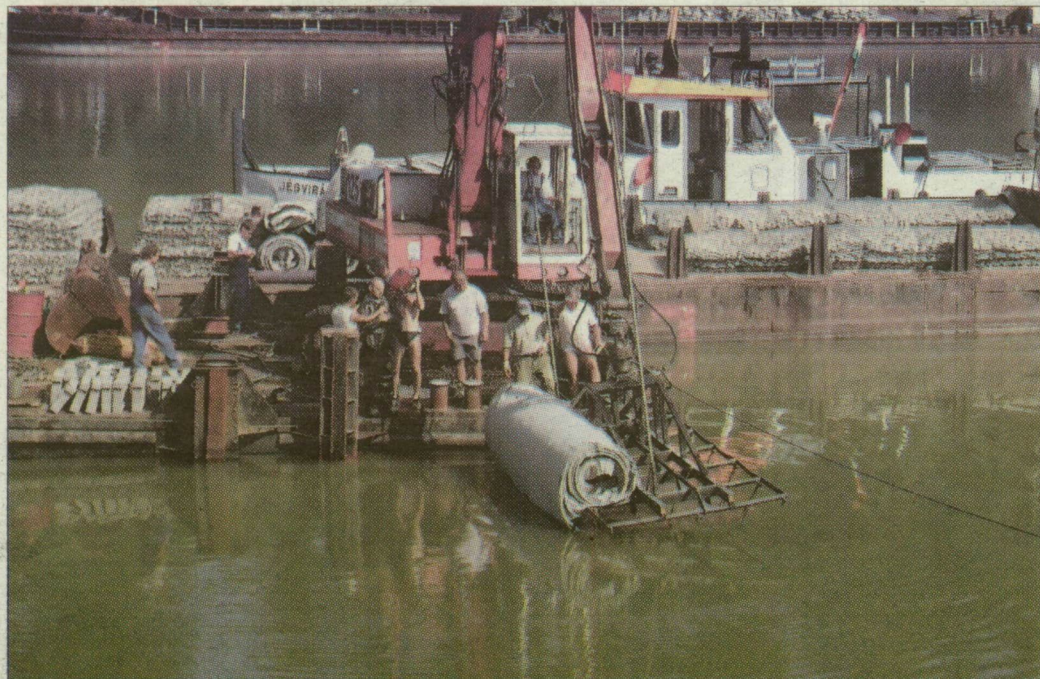
A vízügyi igazgatóság kőpaplanokkal próbálja megvédeni a partot
